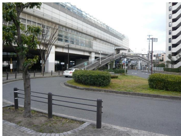
南茨木駅前交通広場と 大阪モノレール南茨木駅
