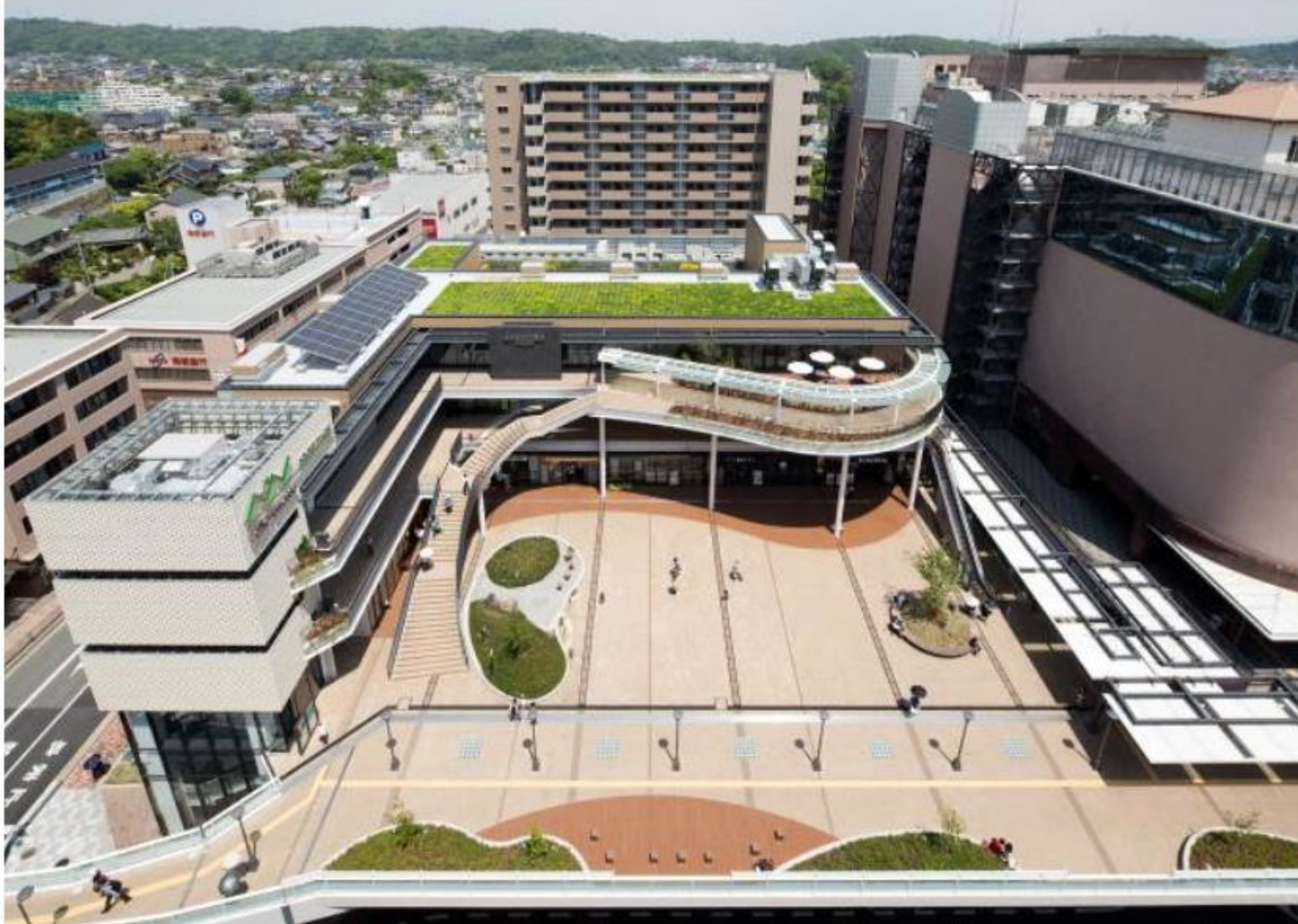
歩行者専用デッキと一体となった賑わい空間「ベルステージ」
